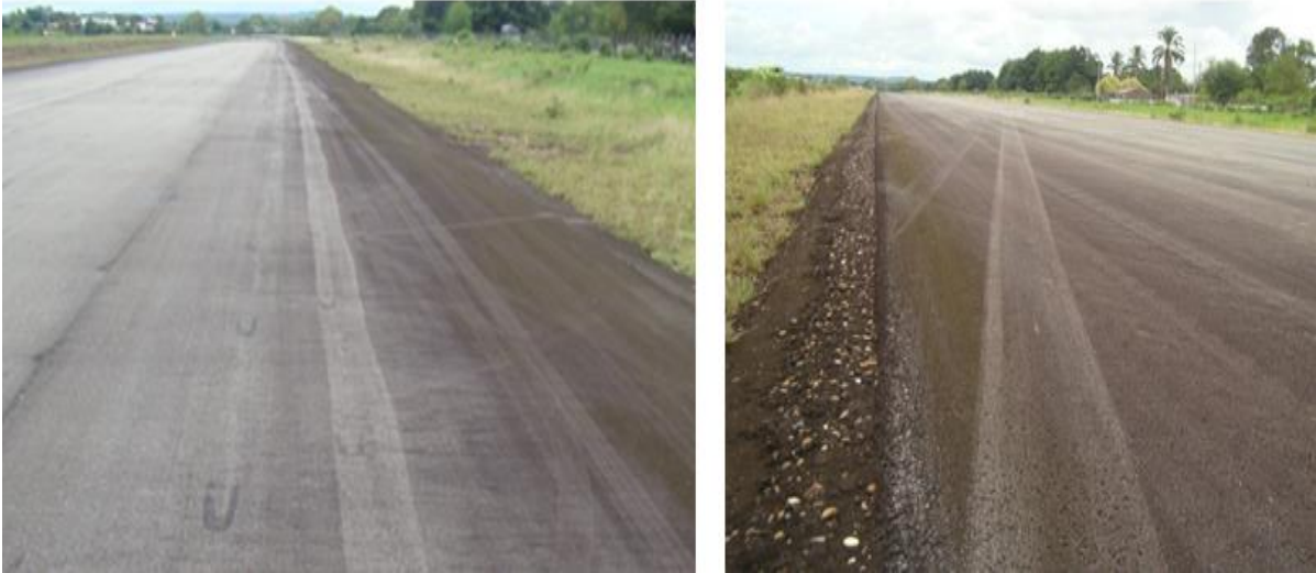
Gráficas de las marcas irregulares en pista ruedas No 01 y 02 (izquierdas) del tren principal y de la excursión de pista de la aeronave HK4728 el 07 de Junio de 2014 en SKSJ
