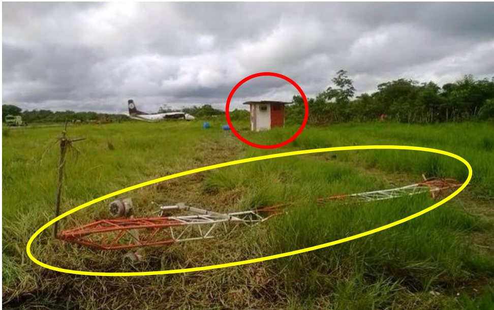
Estado final de la antena EMA, accesorios y cubierta caseta de Vigilancia
